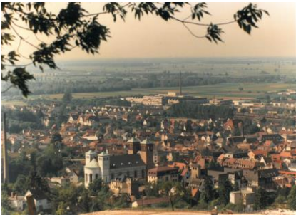
Abb. 1: So fing es an: Ein kleiner Industriestandort im Südwesten von Bensheim für die Siemens Ringier Werke, Erlangen.
